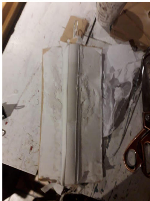
Desmontando la tela del pilar n°2
