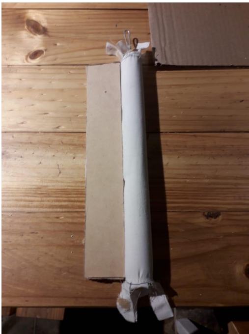
Desmontando las piezas del molde del pilar n°2
