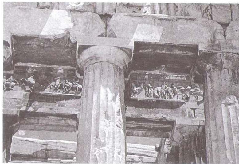
Lámina 23. Ninguna fotografía puede hacer justicia al Partenón, pero esta imagen de la esquina suroeste puede dar una ligera idea. (Nótese que el dintel de la derecha está agrietado; por esta razón se han triplicado los arquivates.)
