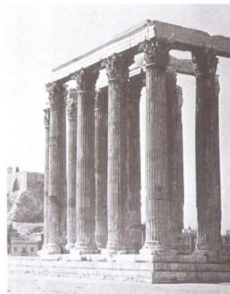
Lámina 8. Parte del enorme templo de Zeus Olímpico en Atenas. Fue construido según el orden Corintio por el emperador Adriano hacia 138 d. C. Se ve que uno de los arquivados está agrietado. Nótese que las murallas de la Acrópolis se levantan por encima del templo de Adriano.
