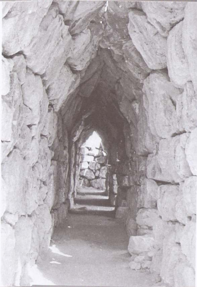
Lámina 5. Falsa bóveda de Tirinto (hacia 1800 a. C.). Los falsos arcos y bóvedas precedieron al verdadero arco.
