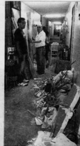
Aisladores minimizan daños.
